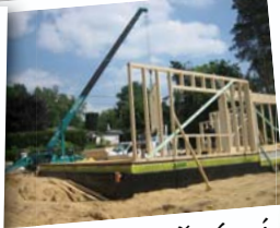
Práce s dřevěnými konstrukcemi
